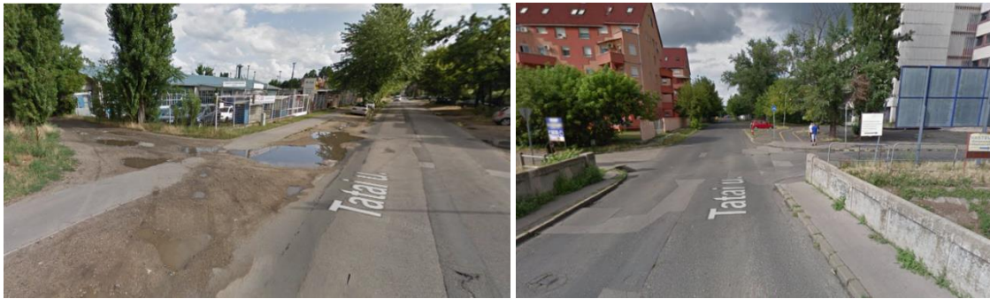
27. ábra: Balra - Saras felhordás a kerékpárúton Jobbra - Folytonossági hiba a Rákospatak felett (forrás: Google Maps)
