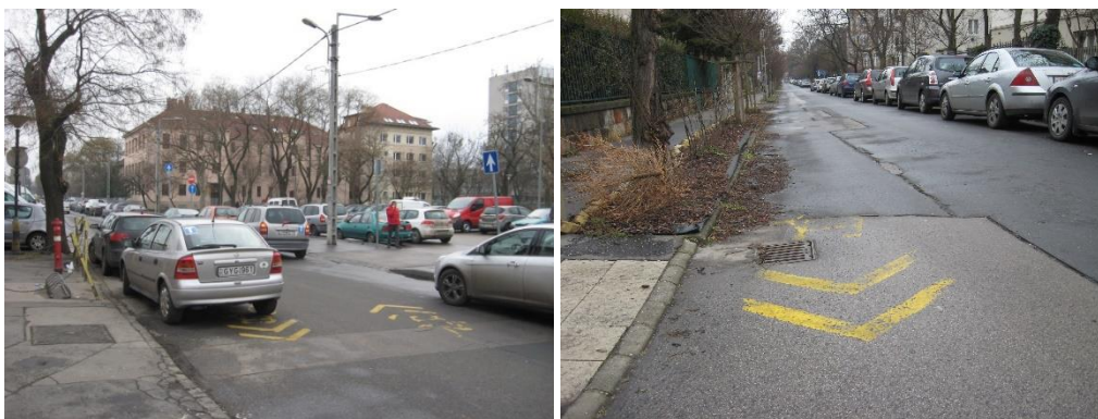
50. ábra: Balra - A kerékpáros forgalom számára két irányban megnyitott egyirányú utca szabálytalan parkolással (Lőcsei út) Jobbra - Lekopott kerékpáros nyom (Columbus utca)
