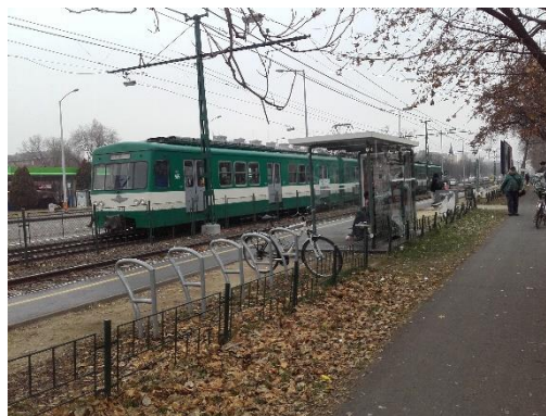
52. ábra: Jó példa: Rákosfalva HÉV állomás költséghatékony „B+R” parkolója. Fejlesztési lehetőség: tető építése
