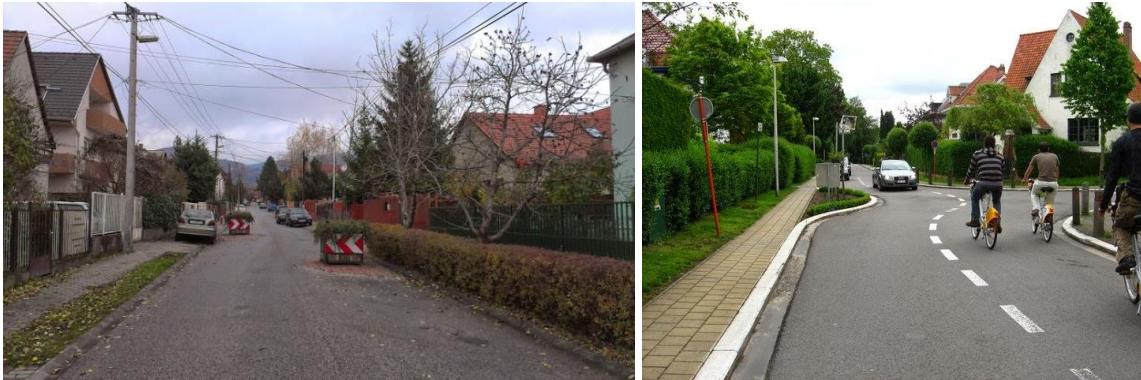
76. ábra: Balra – – Példa jól működő, egyszerű sebességcsökkentés alkalmazására virágládákkal (Budaörs) – a hosszú egyenes út megtörésével esztétikusan csökkenthető a sebesség. Hasonlóan jó megoldás van a Bátorkeszi utcában Jobbra – Sebességcsökkentés sávelhúzással 55
