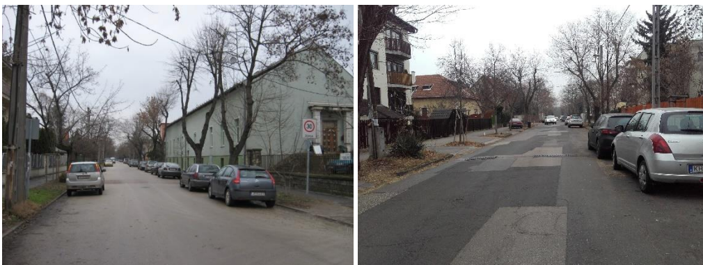
47. ábra: Korlátozott sebességű övezet és széles forgalmi sáv. A sebességcsökkentő küszöb ellenére az út csábít a gyorsajtásra. Az önmagát magyarázó környezet megteremtéséhez hatékonyabban kell alkalmazni a fizikai forgalomcsillapítás eszközeit. Ebben az utcában helyenként az útpálya szűkítése és/vagy sávelhúzás is megoldást jelenthet.
