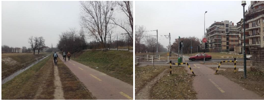
40. ábra: Balra - A kerékpárutas szakaszokra jellemző, hogy párhuzamos gyalogos felület hiányában a gyalogosok is a kerékpárutat használják, több helyen kítaposított ösvény vezet a kerékpárút mellett. Jobbra - A behajtásgátló elem kialakítása tovább szűkíti az egyébként is keskeny felületet, lehetetlenné téve a kétirányú használatot.
