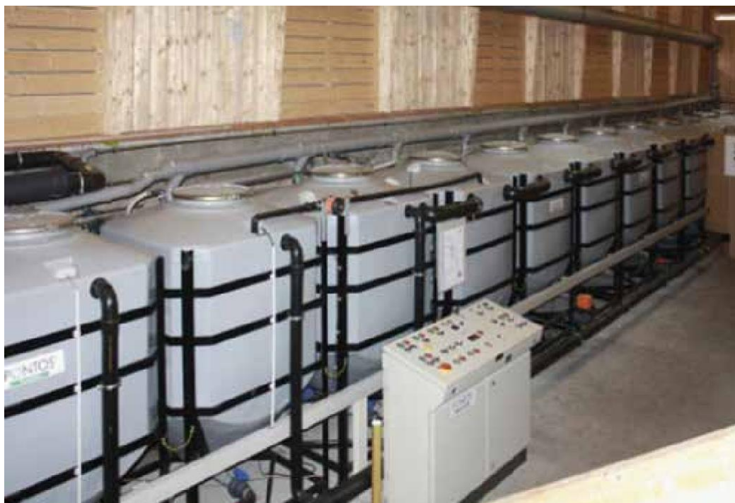
12. ábra: Többlépcsős mozgóágyas biofilmreaktor (MBBR) a szürkevíz újrahasznosítására egy lakóépületben (Fotó: F: E. Nolde).
