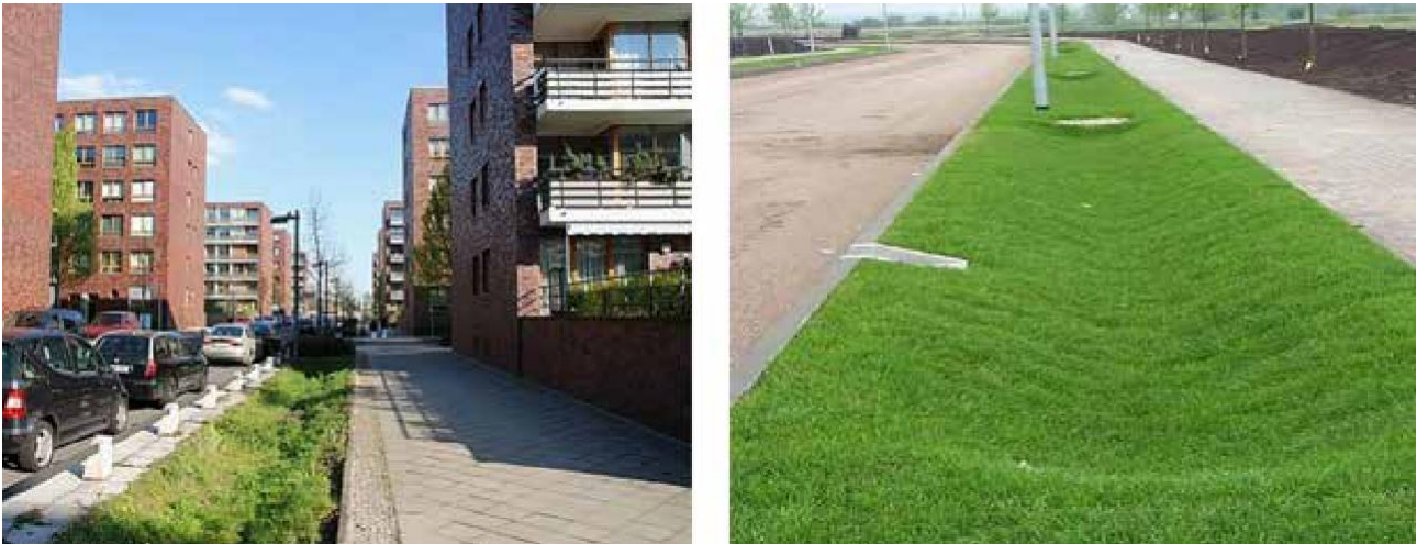
44. ábra: Füvesített árok-beszivárogtató blokk rendszerek Berlinben (Sieker).
