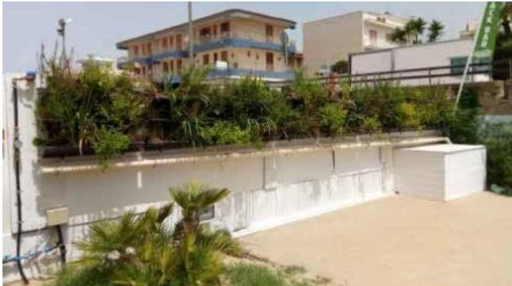
19. ábra: Zöldfal a kezelt szürkevíz kertészeti újrafelhasználására, Margarita strand, Marina di Ragusa (RG - Olaszország) 45 .
