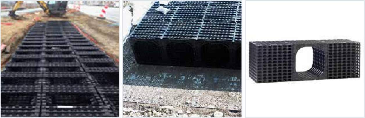
43. ábra: Árokelemek (beszivárogtató dobozok) füvesített árok-beszivárogtató blokk rendszerekhez (ENREGIS).
