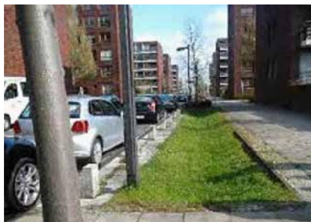
36. ábra: Füvesített árkok lakott területeken (Sieker).
