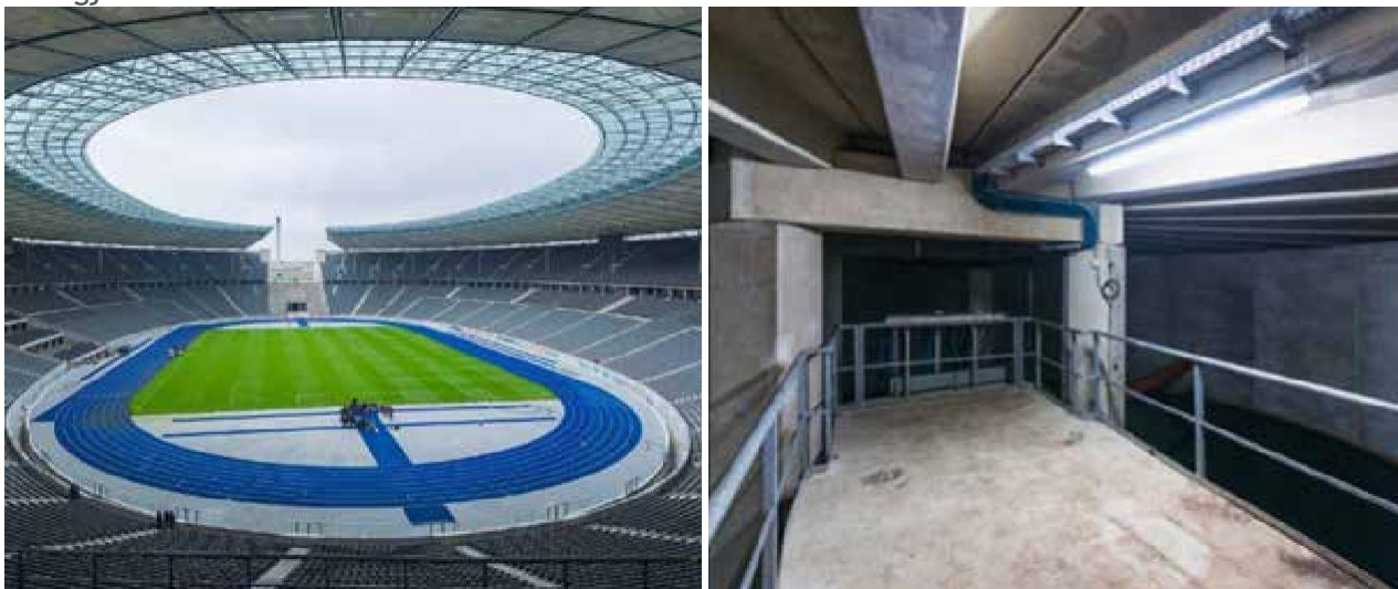
50. ábra: Berlini Olimpiai Stadion az esővíz gyűjtésére szolgáló lelátótetővel (balra) és földalatti esővízgyűjtő ciszternával, különböző tárolási szintekkel 45 .
