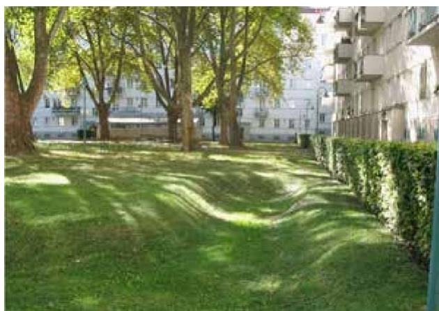
36. ábra: Füvesített árkok lakott területeken (Sieker).
