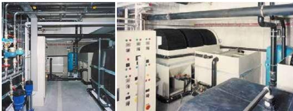
28. ábra: A szürkevíz-újrahasznosító rendszer a 6 RBC-modullal és az utőülepítő tartállyal.
