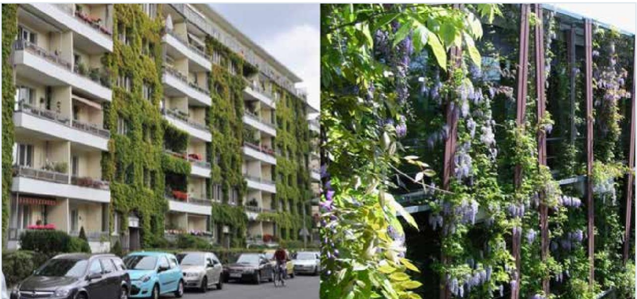
17. ábra: Földhöz kötött zöldfal Virginia kúszónövénnyel (balra, Fotó: F. D. Kaiser) és rendszerhez kötött zöldfal a Berlin-Adlershoferi Fizikai Intézetben (Fotó: F. M. Schmidt).
