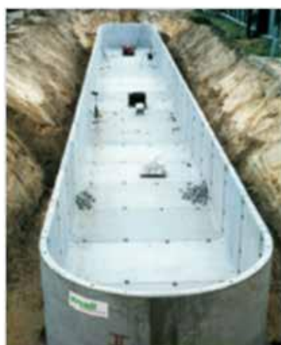
Vasbeton ciszterna (24 - 100 m 3 ) (Mall)
