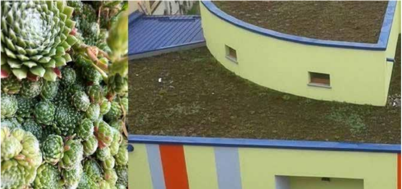
14. ábra: Extenzív zöldtető - sedum, sempervivum - Paguro gyermek játszótér, Torino (Fotó: A. Aires).
