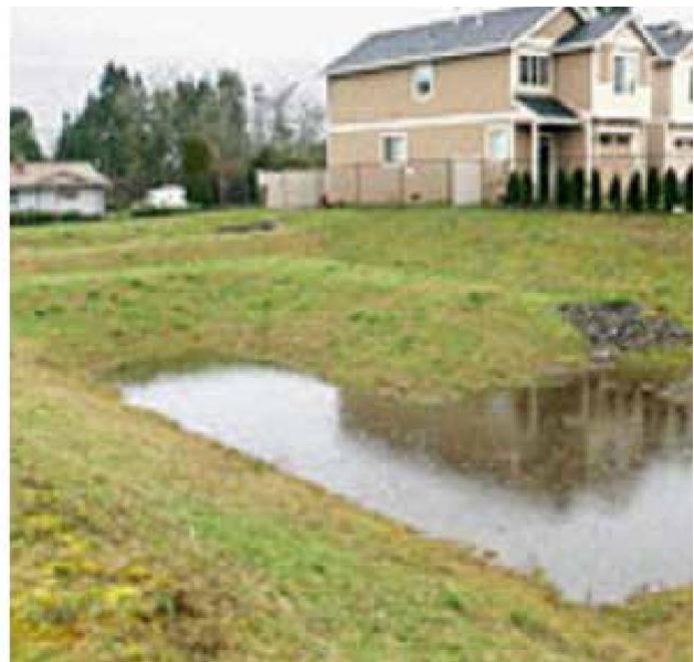
38. ábra: Üres 37 és feltöltött beszivárogtató medence 38 .
