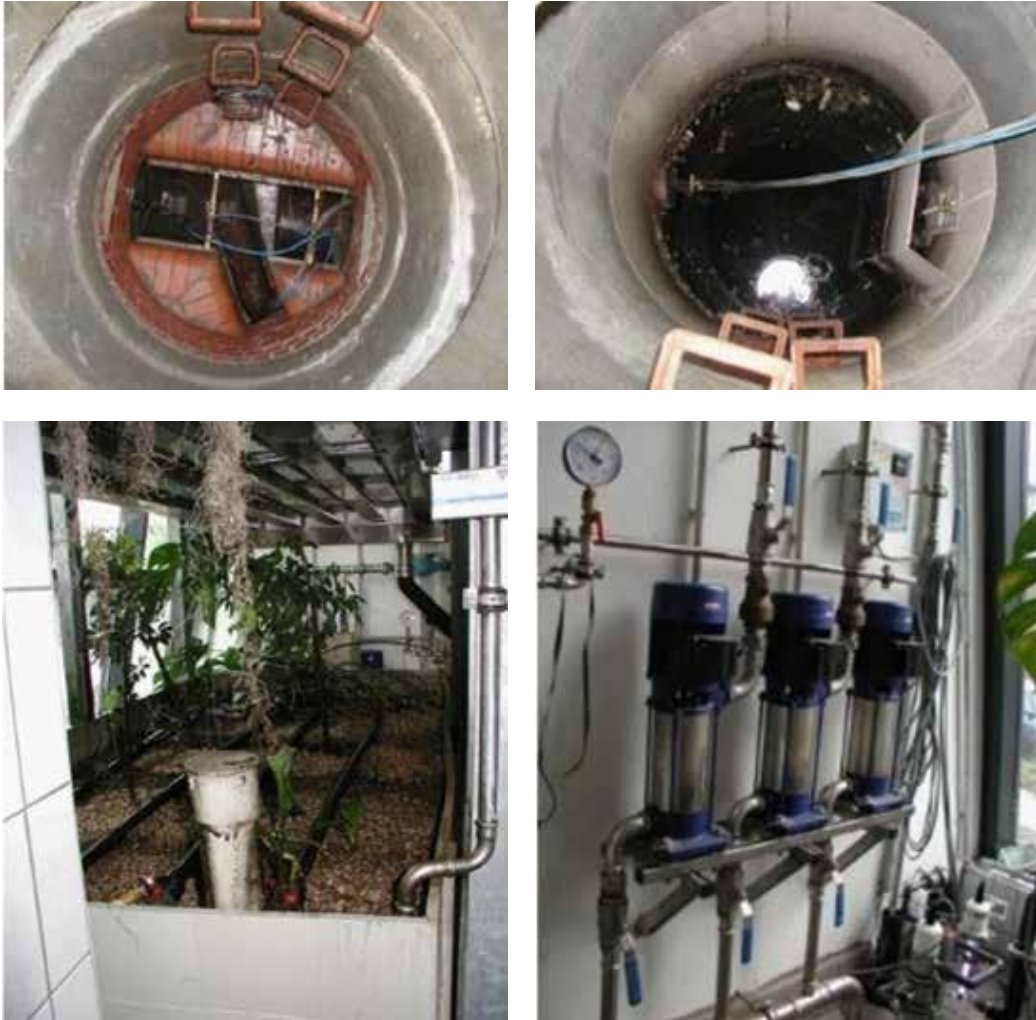
47. ábra: Esővízcsatorna kapcsolóterelővel (fent) és az épület belsejében lévő talajszűrővel (lent).
