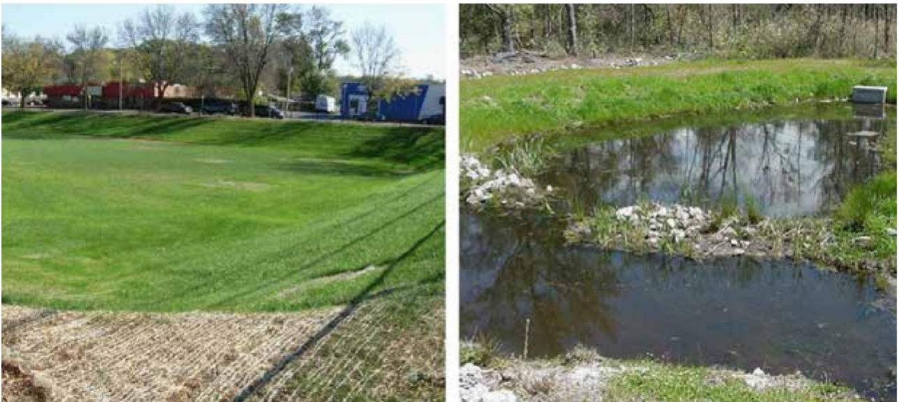
27. ábra: Vízvisszatartó medencék száraz és nedves időszakokban 34 .
